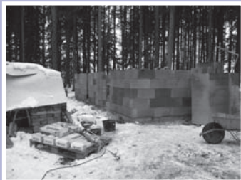
Generální rekonstrukce toalet v Dobré Vodě u Telče
